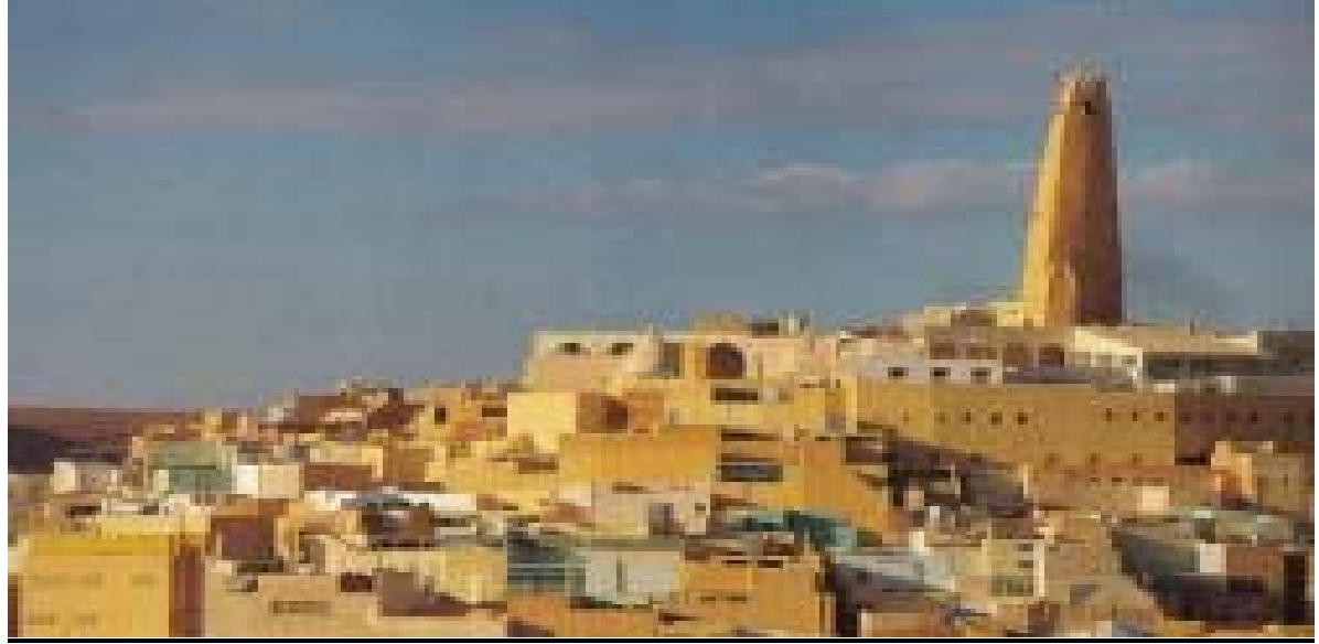
صورة رقم ١: منظر عام لمدينة غرداية ( القصر القديم)
